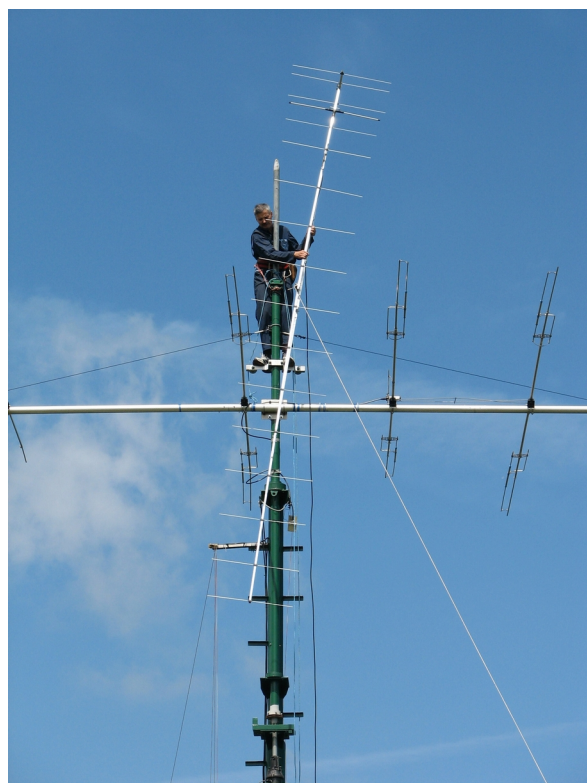
Zorko Kralj S51IV sestavlja jagi anteno za 2 metra, Marko Praprotnik S57MPU pa jo na vrhu stolpa namešča v pravi položaj.
