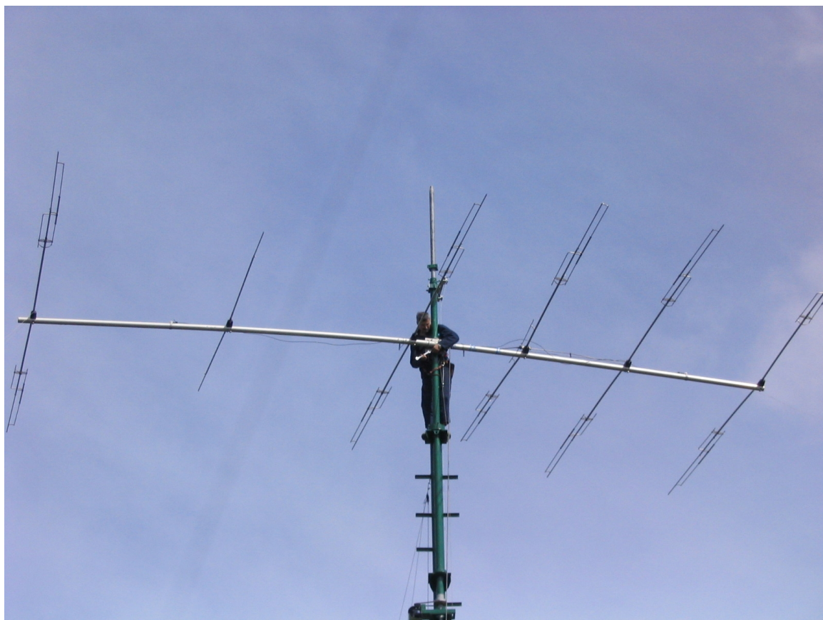
Marko Praprotnik S57MPU pritrjuje to KV anteno na vrh stolpa.
