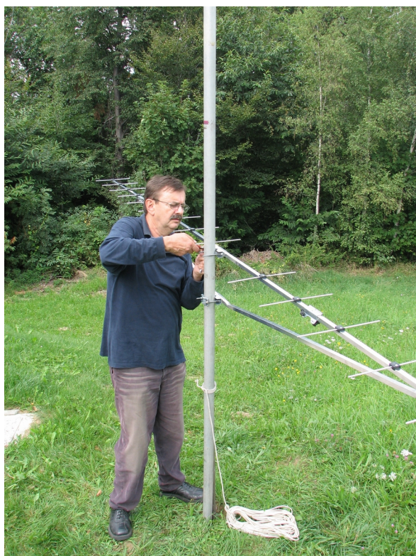
Zorko Kralj S51IV sestavlja jagi anteno za 2 metra, Marko Praprotnik S57MPU pa jo na vrhu stolpa namešča v pravi položaj.
