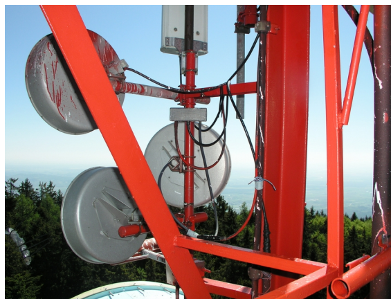
Levo: svitki debelih mikrovalovnih kablov s priključki so pripravljene za namestitve na stolp, desno: mikrovalovne antene za 1.2 GHz in za 2.4 GHz 40 m visoko na RTV stolpu.
