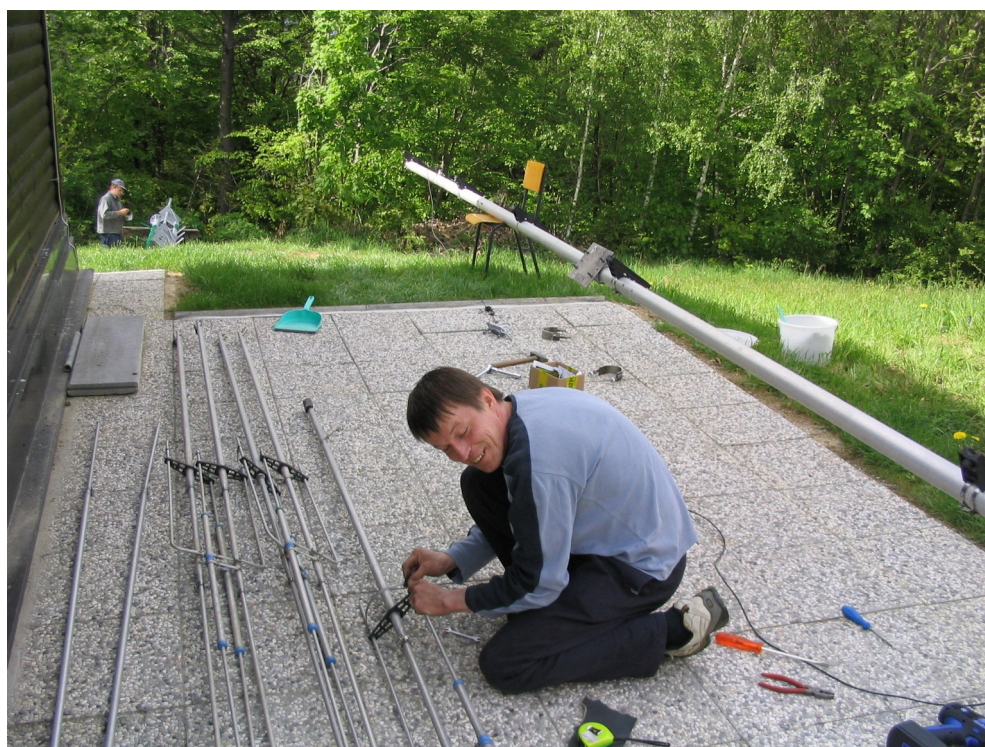
Marko Derganc S51DS sestavlja več elementno kratkovalovno anteno
